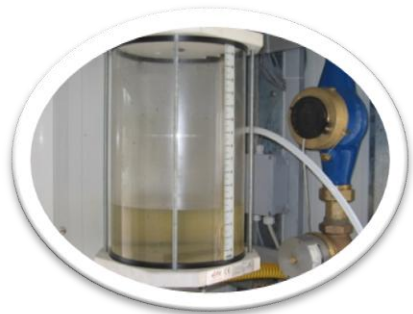
Wagowy układ dozowania dodatków chemicznych
