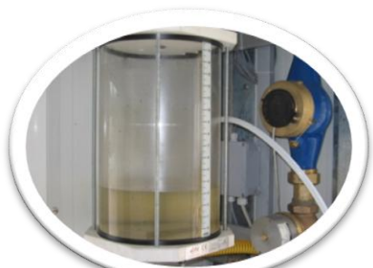
Wagowy układ dozowania dodatków chemicznych
